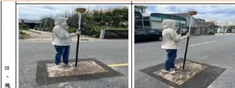
※施工單位於完工後執行管線埋設座標測量
