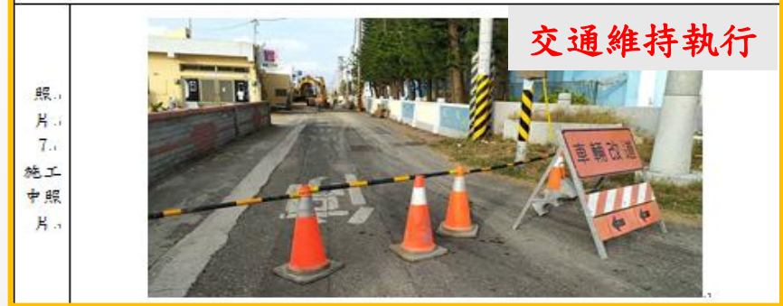
澎湖縣道路挖掘監理現場查驗照片 編號：1100900081.
