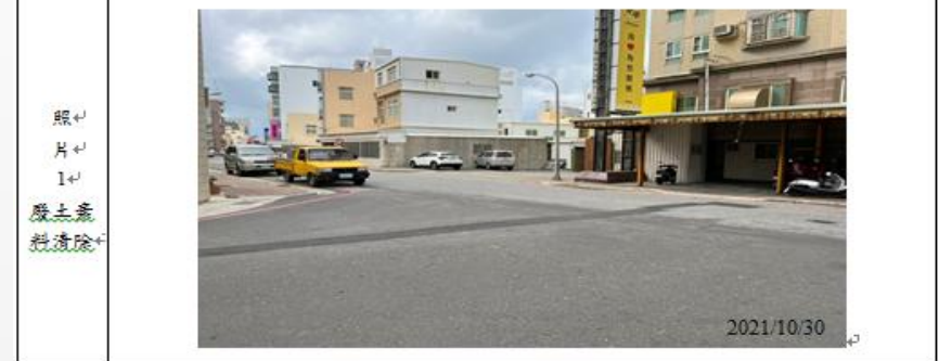
澎湖縣道路挖掘監理完工報告查驗照片 編號: 1100900059
